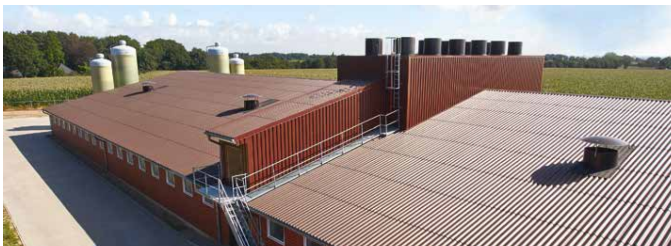
Nybygning af luftrensningsanlæg ved montering på taget mellem to bygninger
