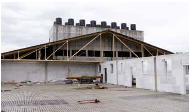
Montering på taget på tværs af udsugningsluftkanal
