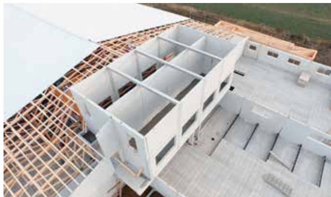
Montering på taget med integreret brandbeskyttelse
