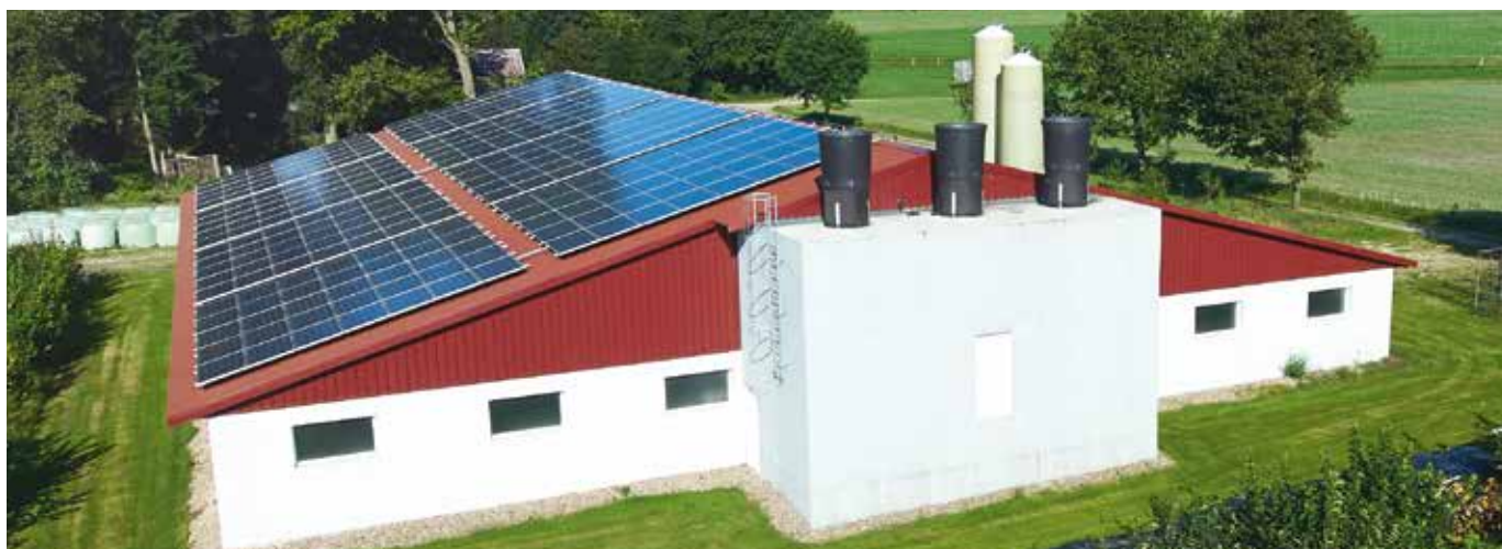
Luftrensningsanlæg monteret ved gavlen i betoncabinet
